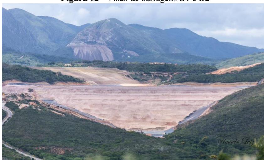
Figura 02 - Visão de barragens B1 e B2
