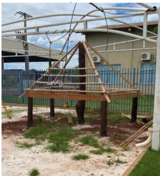
Figura 11. Detalhe da execução da estrutura de cobertura da oca.
