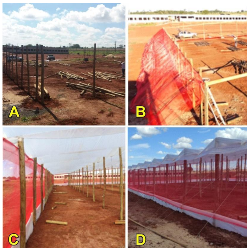
Figura 6 – Construção da estufa de mudas.
