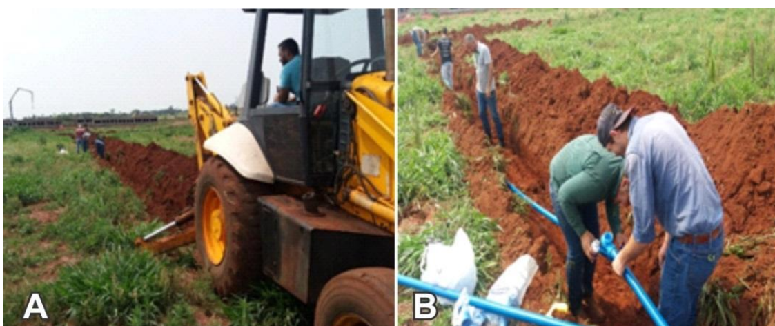
Figura 4. Implantação linha mestra de instalação.
