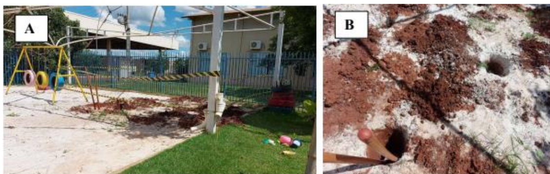
Figura 8. (A) Vista do espaço da oca com as aberturas dos furos para a fundação. (B) Detalhe das aberturas para fixação dos pilares.
