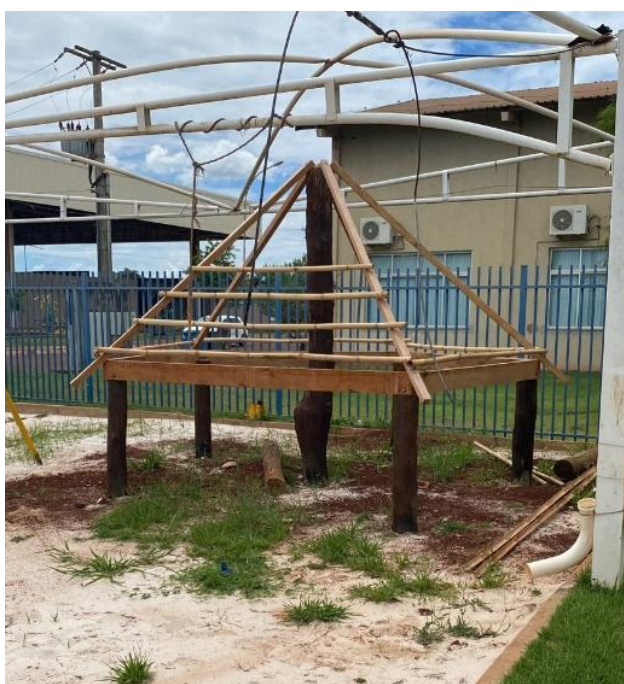
Figura 12 - Detalhe da execução da estrutura de cobertura da oca.
