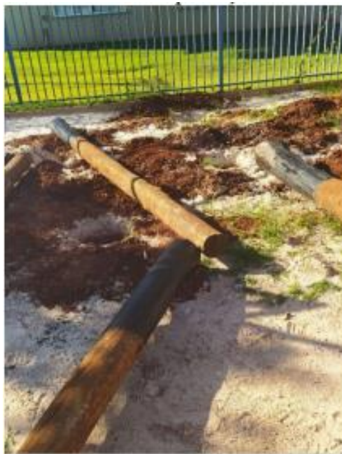
Figura 9. Pilares com aplicação de tinta asfáltica.
