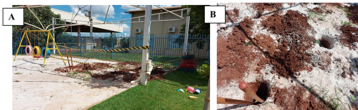
Figura 9 – (A) Vista do espaço da oca com as aberturas dos furos para a fundação. (B) Detalhe das aberturas para fixação dos pilares.
