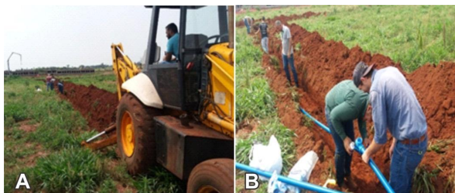
Figura 4 - Implantação linha mestra de instalação.
