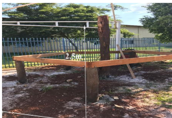
Figura 11 - Detalhe da execução dos pilares da oca.
