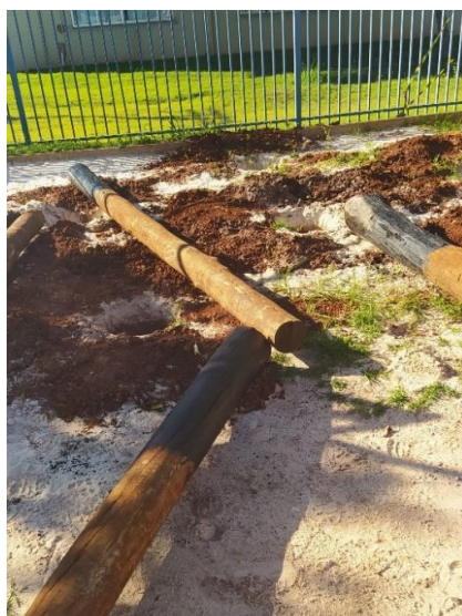
Figura 10 - Pilares com aplicação de tinta asfáltica.
