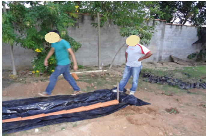
Figura 7. Construção do canteiro ecológico-econômico / Fonte: Acervo do NEPEA.
