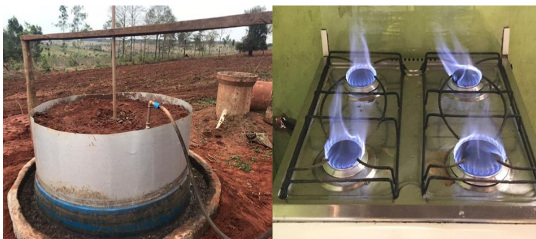
Figura 5. Biodigestor instalado no Assentamento para a geração de biogás.
