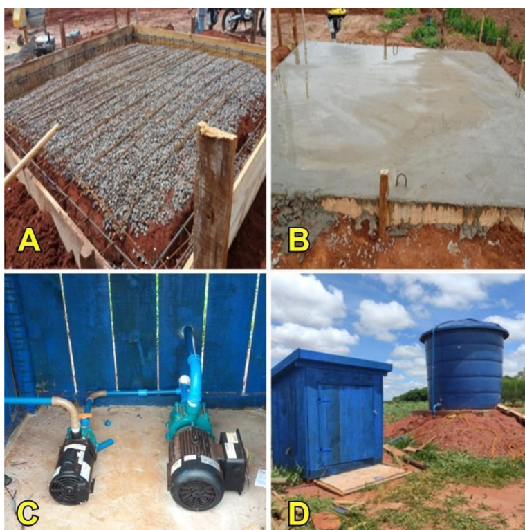
Figura 5 – Instalação do reservatório de água de irrigação e casa de máquinas.
