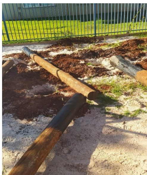
Figura 10 – Pilares com aplicação de tinta asfáltica.
