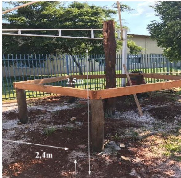
Figura 11 - Detalhe da execução dos pilares da oca.
