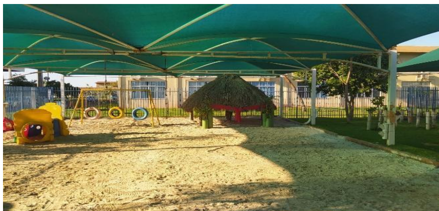
Figura 14 - Oca lúdica e manutenção da estrutura do parque finalizados.
