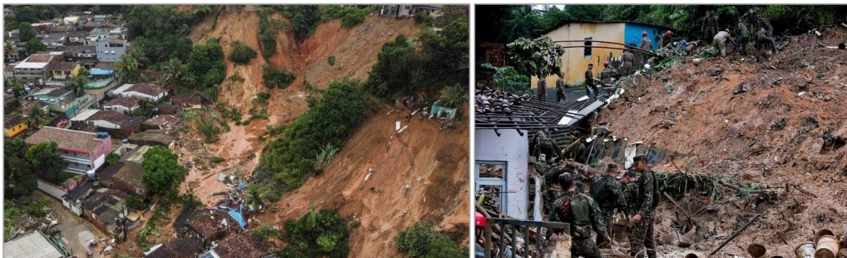
Figura 11 - Deslizamentos de terra decorrentes das fortes chuvas no município do Recife, comunidade de Jardim Monte Verde na Cohab, em 28 de maio de 2022
