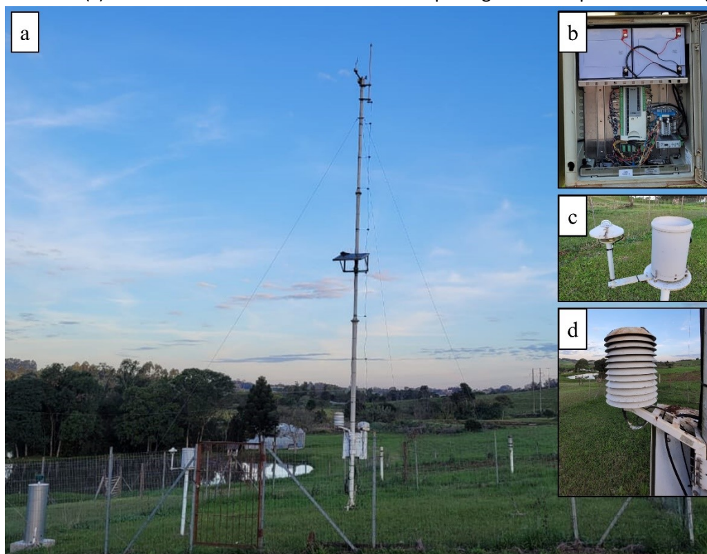
Figura 1 - Estação meteorológica automática de Frederico Westphalen, Rio Grande do Sul, Brasil (a), painel central de armazenamento denominado, Datalogger (b), Piranômetro e pluviômetro basculante (c) e o local onde está localizado o sensor que registra a temperatura do ar (d).
