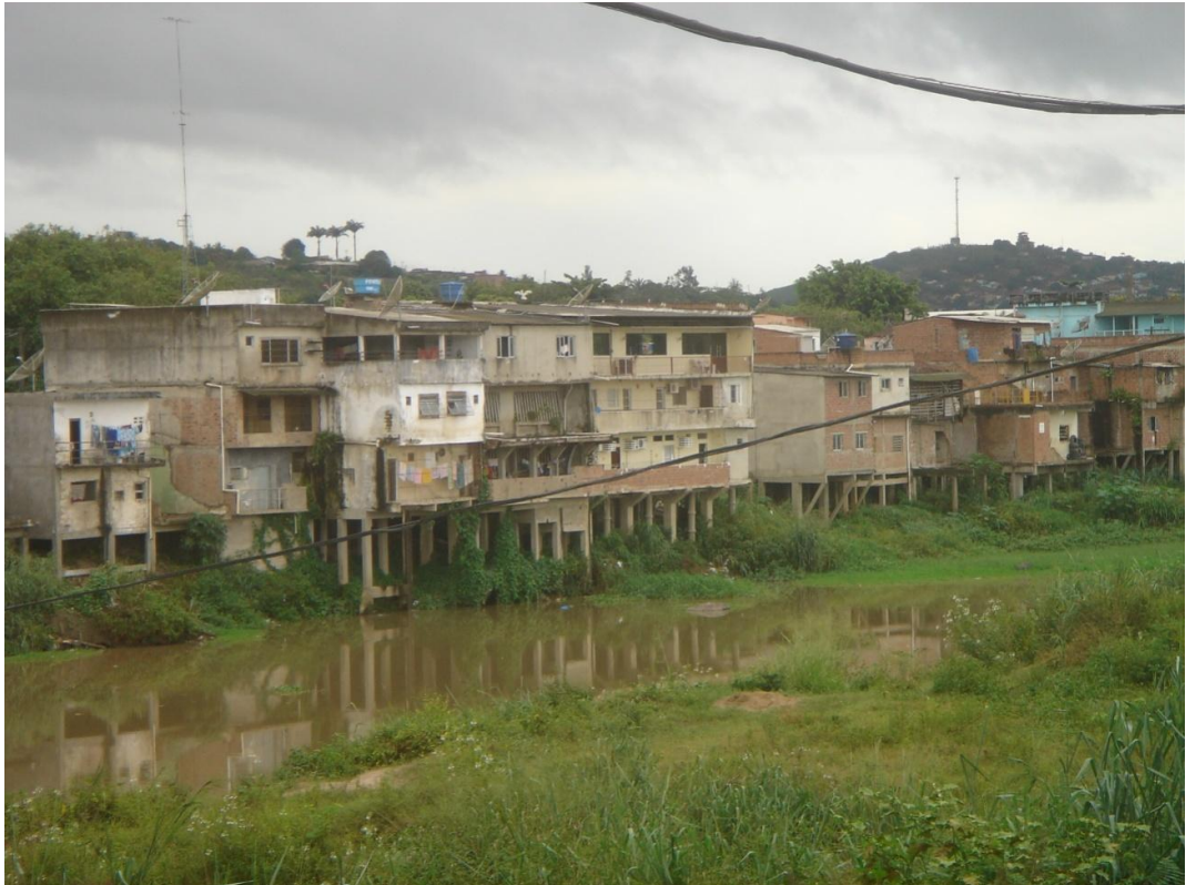
Figura 10 - Foto de casas construídas em cima do rio Una na cidade de Palmares. (Abril, 2011).
