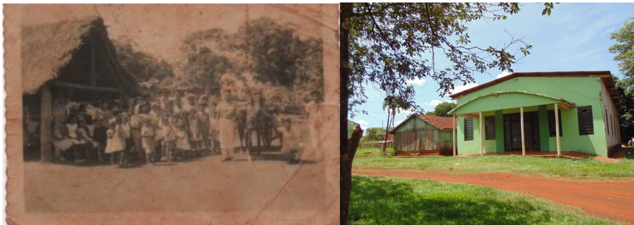
Figura 2. Primeira sede da 1ª Congregação Figura 3. Sede atual (2017)
