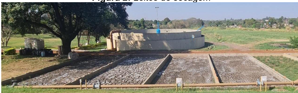
Figura 2: Leitos de secagem
