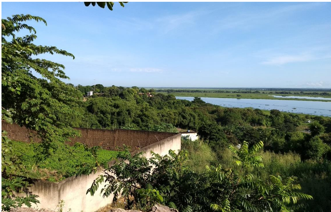
Figura 03 – Muro que impede o acesso da comunidade a Rua Oriental.
