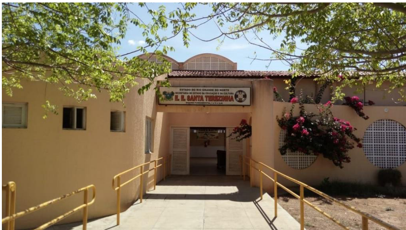
Figura 1: Fachada da Escola Estadual Santa Terezinha, São João do Sabugi/RN. Fonte: Arquivo dos autores, 2018.
