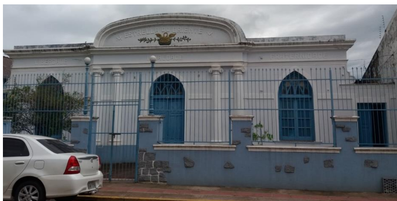
Imagem 20 - Fachada da loja maçônica Estrela do Oriente.
