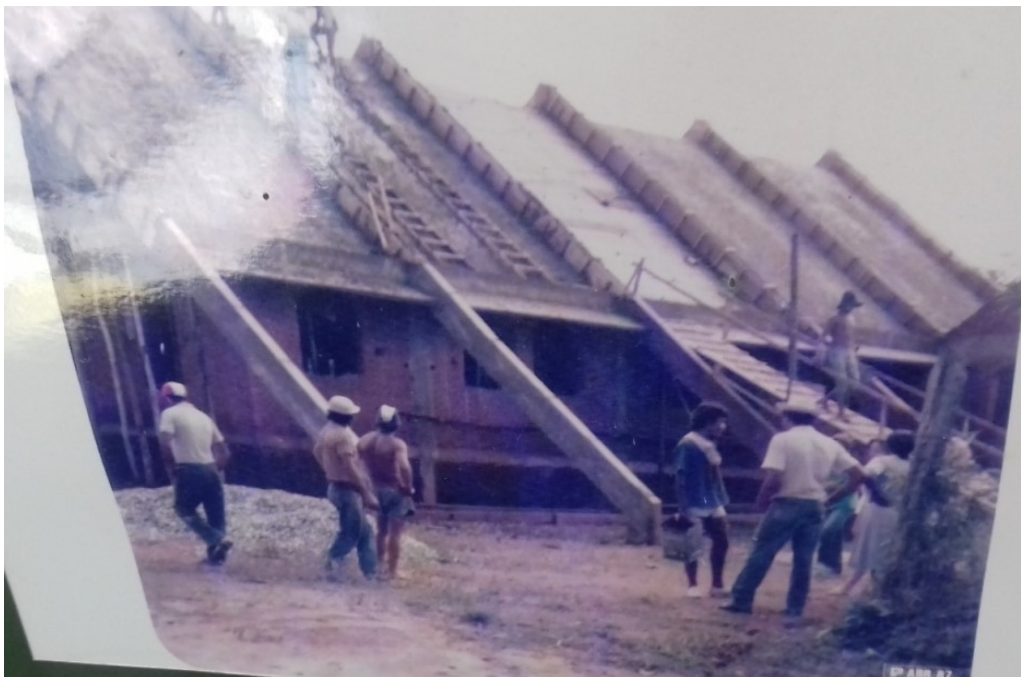
Imagem 02 – A construção da igreja Santa Edwiges. 7
