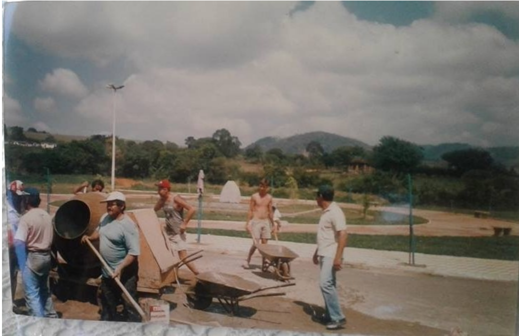
Imagem 03 – O mutirão da construção da Igreja 8
