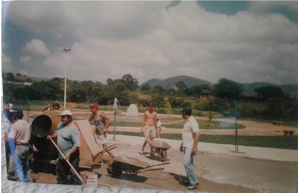
Imagem 03 – O mutirão da construção da Igreja 8
