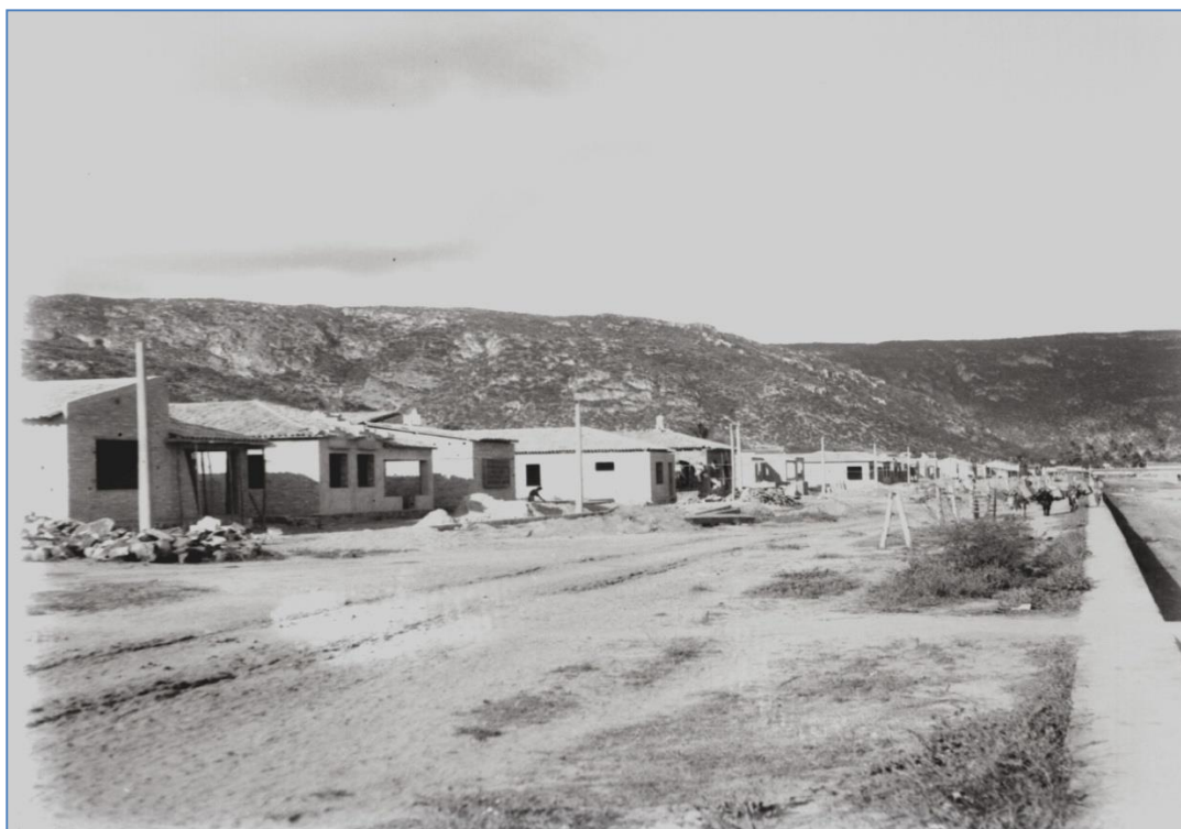
Imagem 1 - Avenida Orlando Oliveira Pires em construção em 1956
