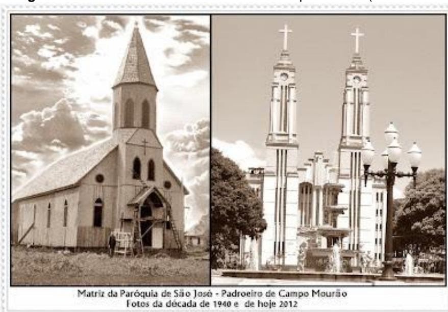
Imagem 3: Catedral São José no centro de Campo Mourão (1940 e 2012)
