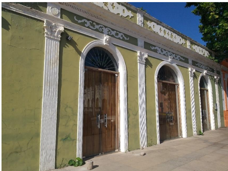
Imagem 15 - Comércio localizado na rua Manoel Cavassa.
