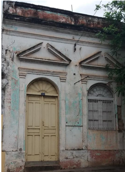
Imagem 12 - Fachada de uma residência localizada na rua Delamare.
