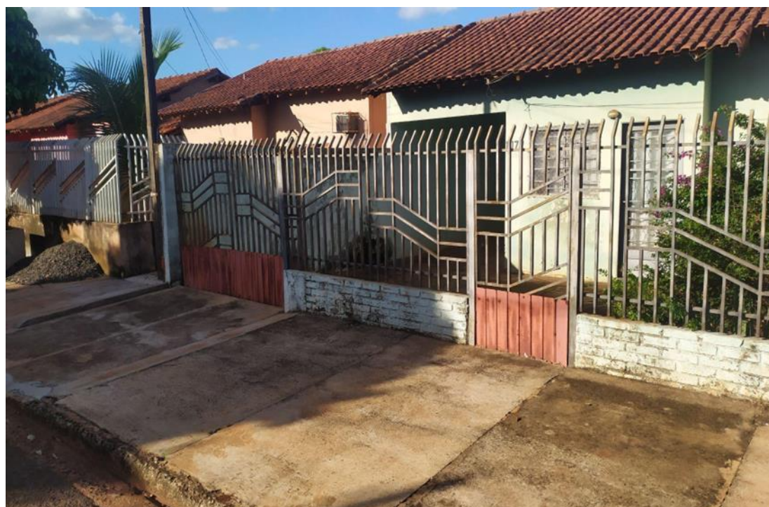
Figura 11 - Vistas da frente de uma moradia no loteamento Jardim Pantanal, rua dos Ipês.
