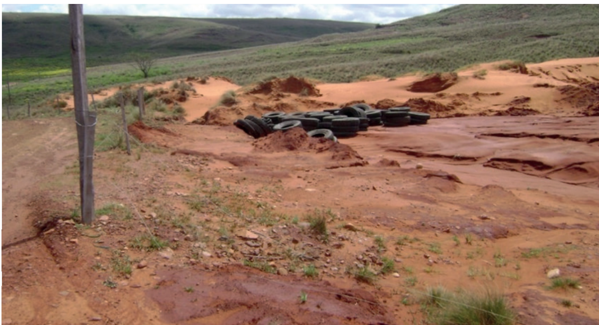
Figura 22 - Barreira constituída de pneus, para conter o escoamento superficial, provocado pela retirada do sedimento arenoso sobreposto. Areal do Cerro da Panela/Figueira, em Quaraí.
