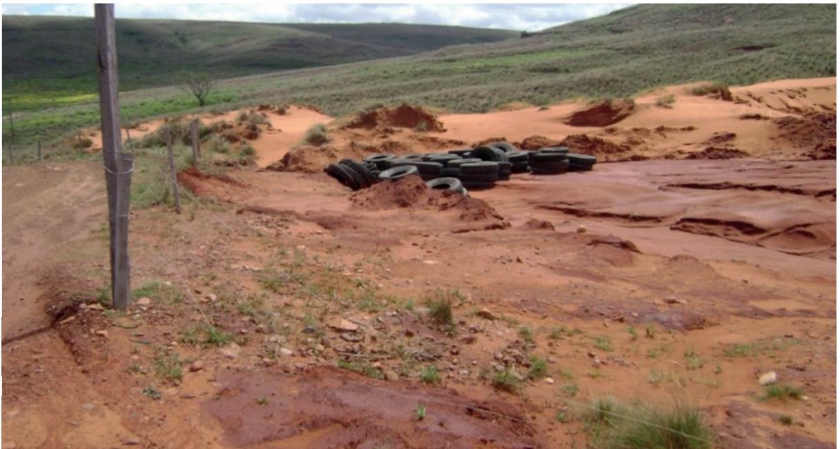
Figura 22 - Barreira constituída de pneus, para conter o escoamento superficial, provocado pela retirada do sedimento arenoso sobreposto. Areal do Cerro da Panela/Figueira, em Quaraí.
