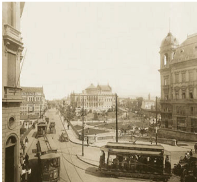
Figura 5 - Viaduto do Chá visto a partir do prédio localizado na esquina da Rua Líbero Badaró, em direção à Rua Barão de Itapetininga (1918) – Autor (Aurélio Becherini).
