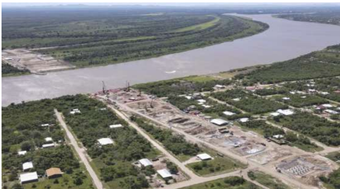
Figura 3 - Construção da Ponte da Rota Bioceânica.
