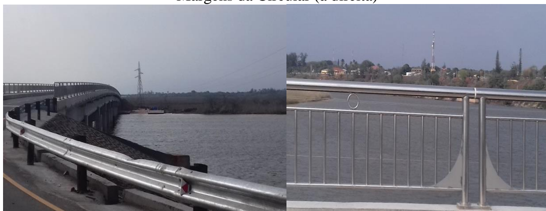
Figura 6: Construção da Ponte chamada Circular (à esquerda) e Margens da Circular (à direita)
