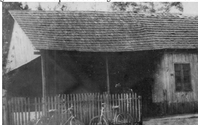
Figura 1 – Primeiro prédio do Colégio Osvaldo Cruz em Dourados
