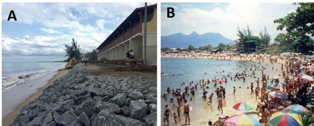
Figura 3: (A) Obra emergencial para a contenção do processo de erosão costeira na praia do Abricó. Foto de Agosto de 2018. (Fonte: Acervo LAGEF). (B) Praia da Tartaruga sem evidências do processo erosivo no ano de 1998. (Fonte: https://www.facebook.com/Sospraiadatartaruga/ ).
