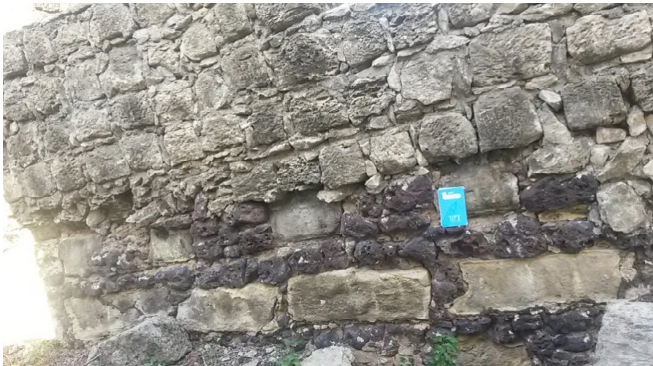
Figura 10 – Georecursos presentes nas paredes de Almagre. No alto, calcários maciços e laminados, e abaixo, mais escuro, os arenitos ferruginosos.
