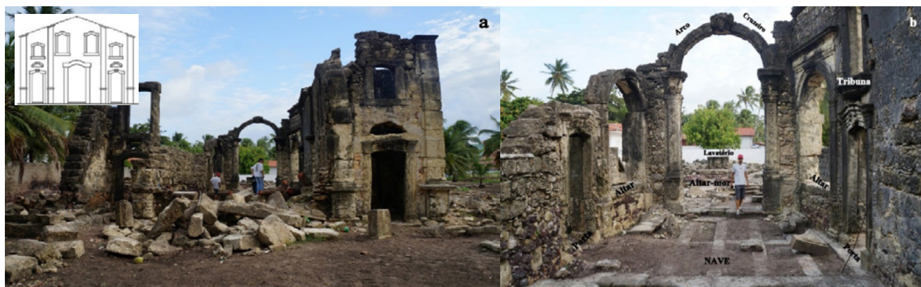
Figura 9 - Ruínas de Almagre. a) Vista da fachada frontal e, em detalhe, modelo da fachada completa. Nota-se que os cunhais da torre estão com risco de desabamento; b) Detalhe de alguns componentes internos da igreja. Fotos: Luciano Pereira.
