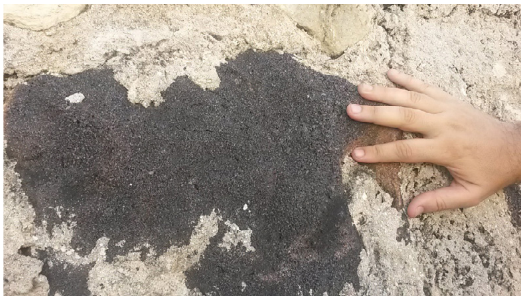
Figura 11 - Detalhe dos arenitos ferruginos de Almagre.
