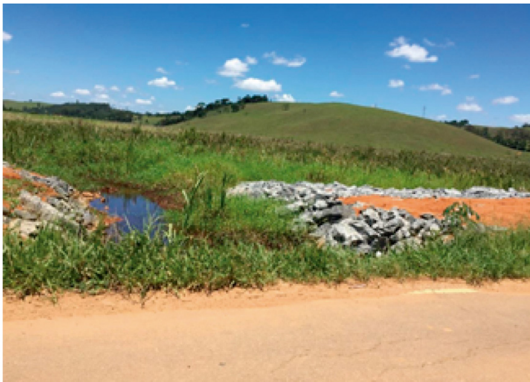
Figura 5: Resíduos das obras da rodovia nas margens do Ribeirão dos Burros, em fevereiro de 2015.
