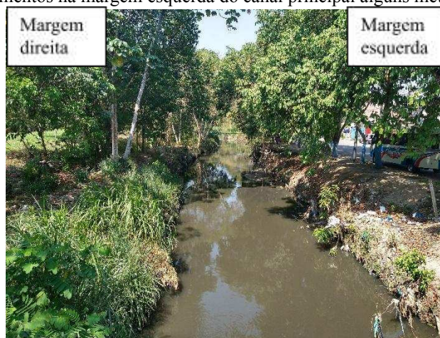
Figura 3: Acúmulo de sedimentos na margem esquerda do canal principal alguns metros a jusante do Ponto 1.
