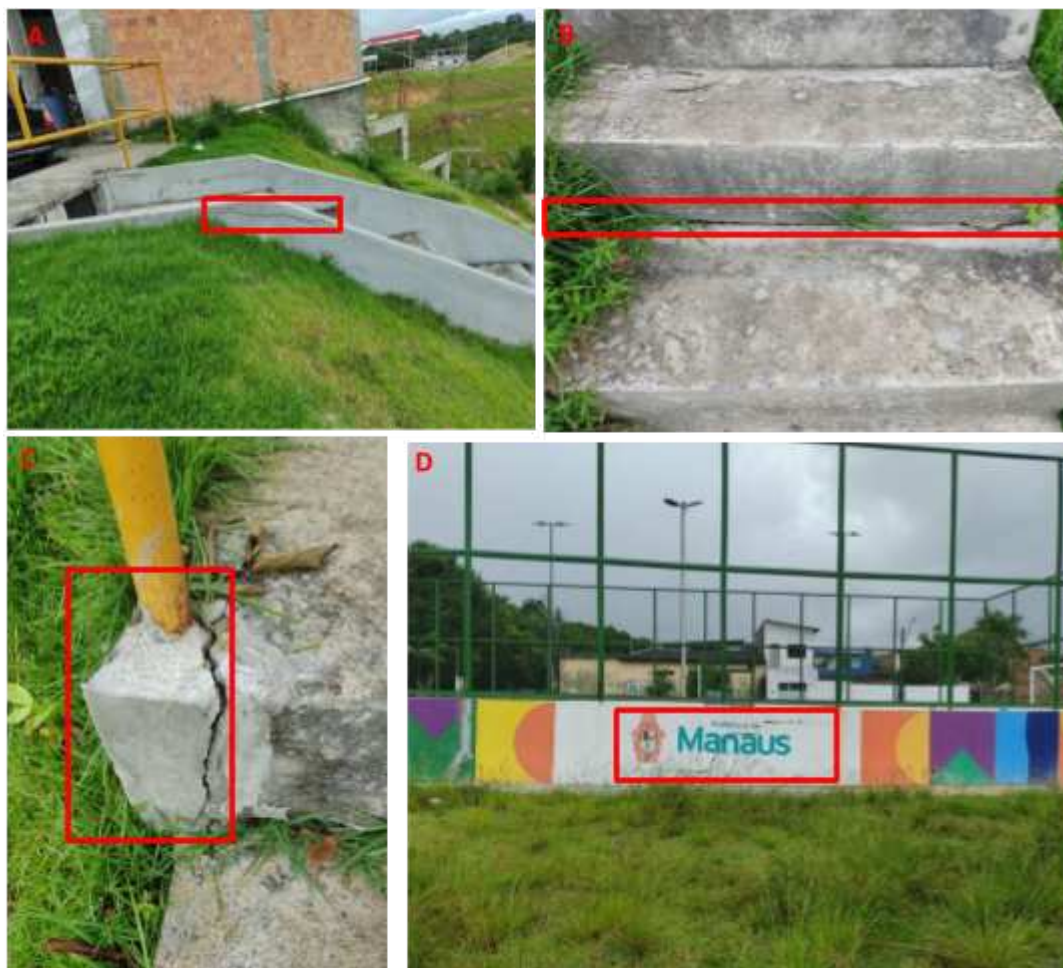
Figura 5. Vícios Construtivos aparentes nas obras de recuperação das áreas de risco a voçorocamento em Manaus. Legenda: Subsidência no depósito tecnogênicos (aterro) causando trincas/fissuras em dissipador de energia (a), escadaria (b) e corrimão para moradores (c) (Rua Salamanca - Nova Cidade) e campo de futebol (d) (rua Budapeste - Nova Cidade). Fonte: Trabalho de Campo (novembro/2022). Elaboração Própria.
