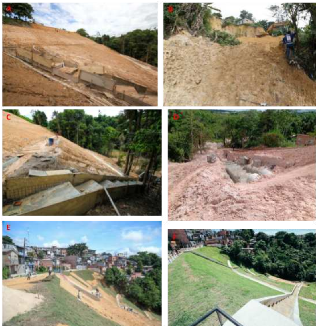
Figura 4. Características comuns das obras em áreas de risco a voçorocamento em Manaus. Legenda: Reconstrução/estabilidade dos taludes (a – Conjunto Cidadão IX; b- Conj. Vila Real); reconstrução dos sistemas hidráulicos (c - Conjunto Cidadão IX; d – Mauazinho); revestimento das banquetas com grama em placas ou através de hidrossemeadura (e/f – Mauazinho). Fonte: Prefeitura Municipal de Manaus (2022). Elaboração Própria.
