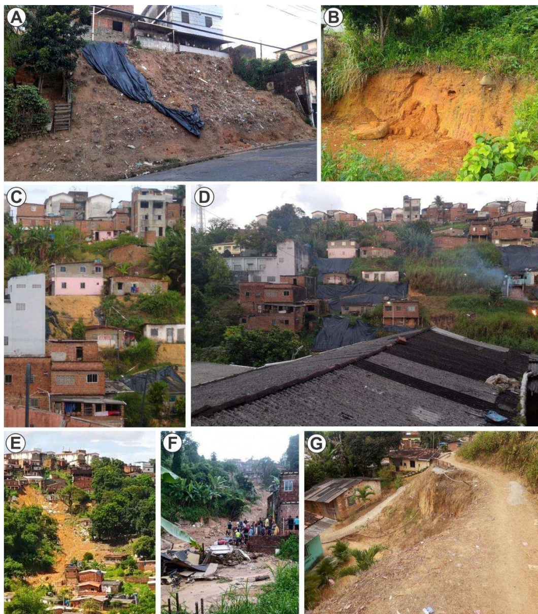
Figura 9 – A) Encosta com casas no topo e presença de encanações de água servida no Setor 06; B) Corte recente realizado em encosta para edificação de residência no Setor 05. C) Domicílios localizados próximos ao limite de encostas expostas no Setor 03. D) Lonas em maioria dos domicílios do setor e queima de lixo domésticos realizado por moradores no Setor 03; E) Cicatriz do escorregamento que vitimou 6 pessoas em 28 de maio de 2022 no Setor 04. F) População local na realização da busca pelas vítimas no dia da deflagração no Setor 04. G) Encosta em forma de anfiteatro com altura de 8 metros, casas localizadas próximas a base no Setor 01. Fonte: Autores, (2022).
