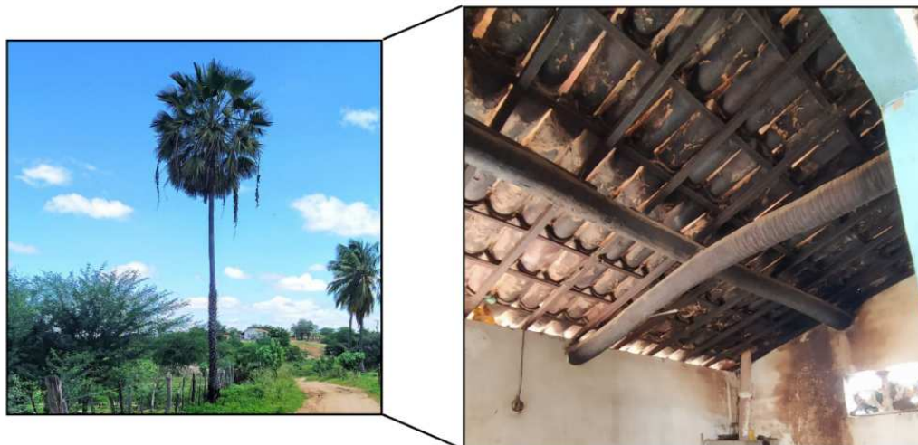
Figura 6 – Utilização da carnaúba para construção de habitação.
