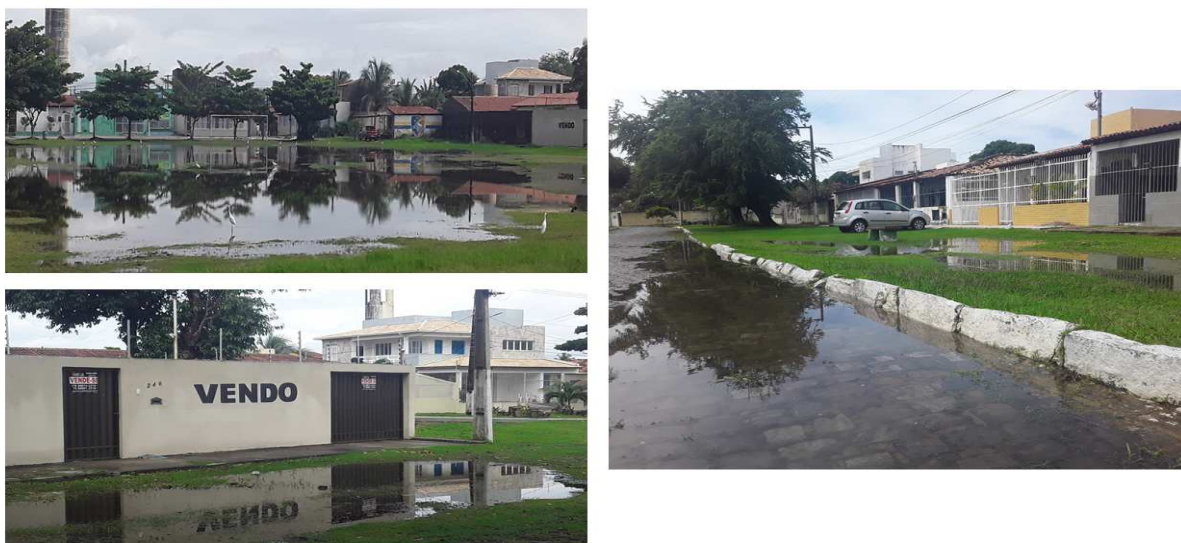
Figura 10 – Pontos de alagamento no bairro Atalaia Nova.
