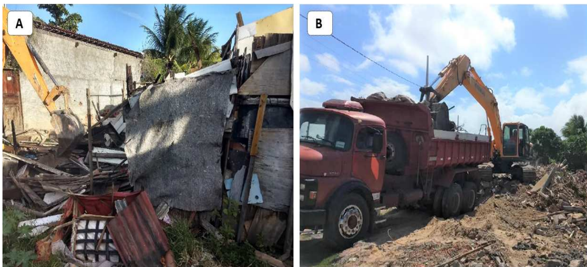
Atividades de demolição no setor Travessa dos Pedreiros. B – Limpeza pós-demolição na Travessa dos Pedreiros.
