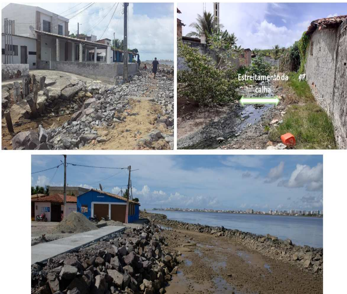
Figura 5 – Habitações situadas em áreas de risco de inundação na Travessa dos Pedreiros.
