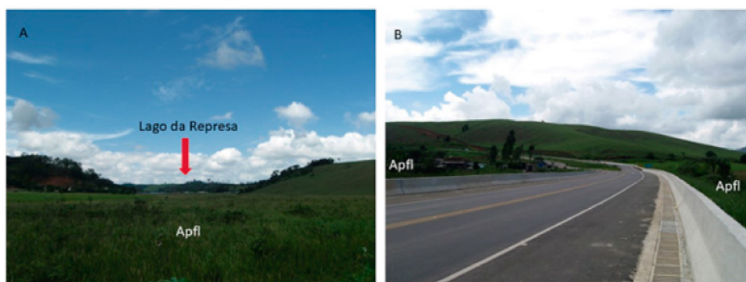
Figura 4: A) Vista frontal da planície fluvial lacustre no córrego Grama, com vegetação de gramíneas e, ao fundo, o lago do manancial; B) vista lateral da rodovia de interligação, impermeabilizando parte da planície observada em A. Fotografia de Carolina C. Eduardo (fevereiro/2019).
