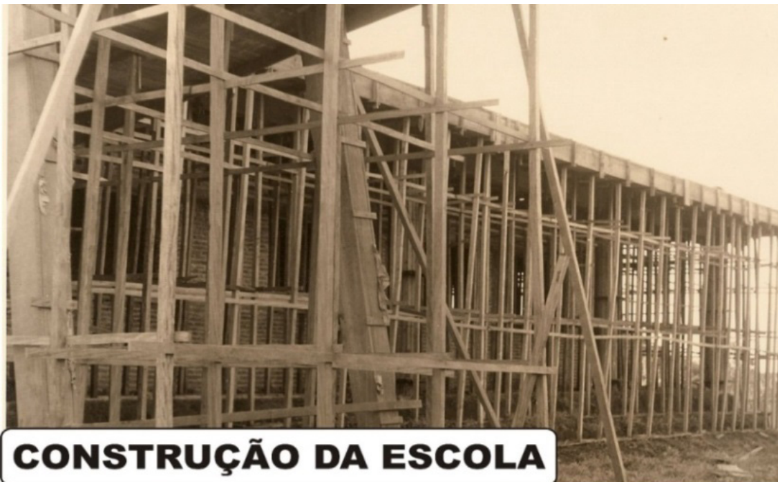
Fotografia 2: Construção do Ginásio Comercial Vicente Pallotti (1962)
