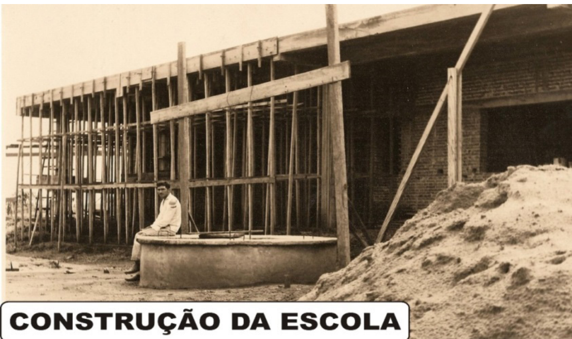
Fotografia 3: Construção da Ginásio Comercial Vicente Pallotti (1962)
